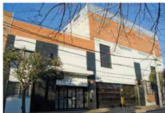
VISTA EXTERIOR DE LA PLANTA
